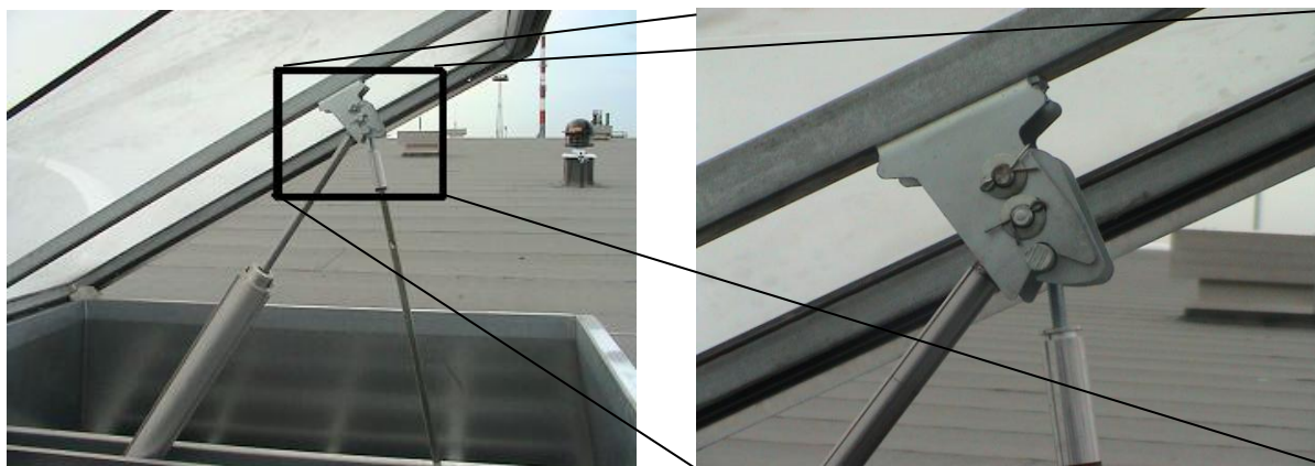
Rys. 50 Połączenie siłownika z konsolą hakową.
